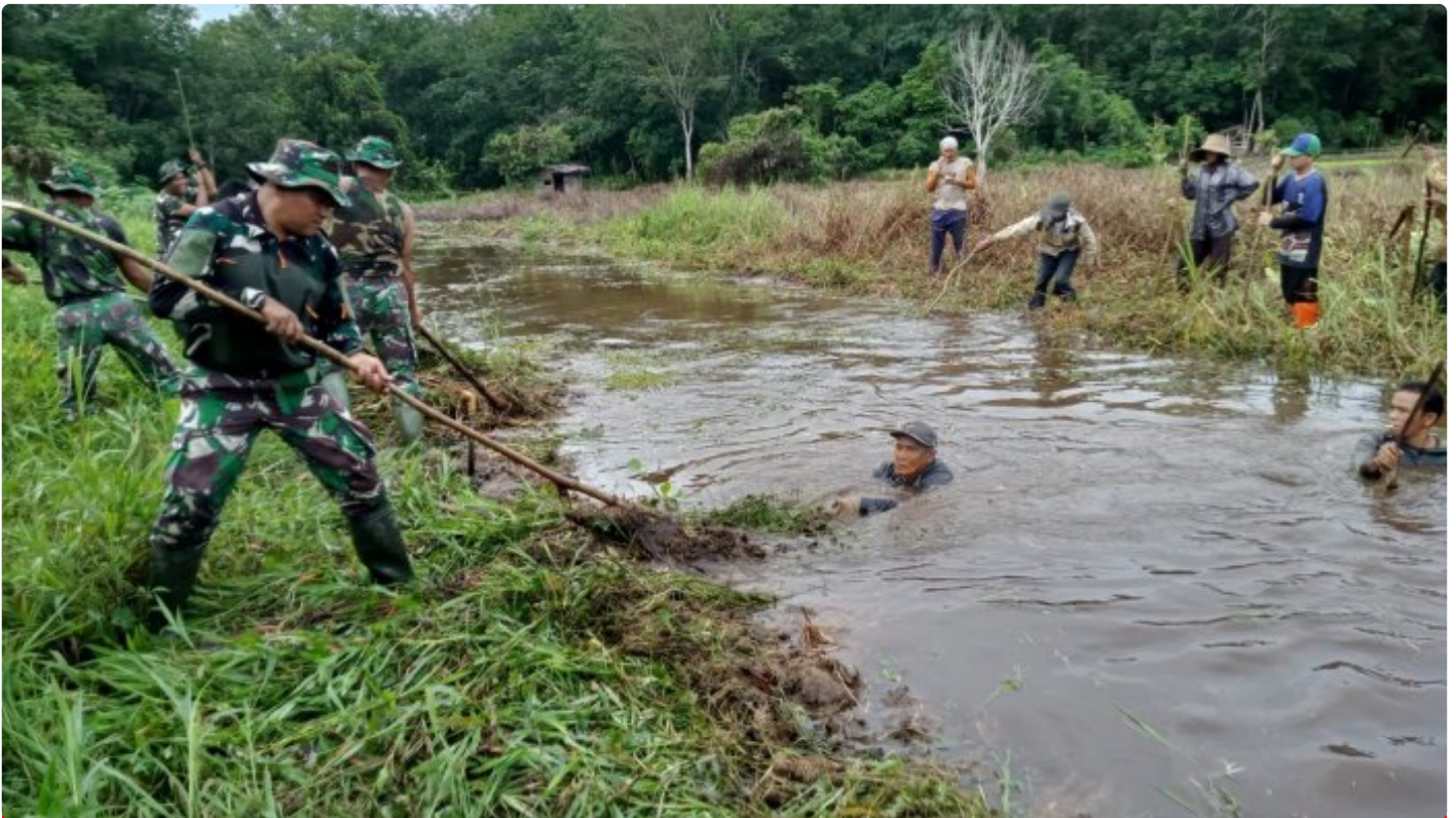
Cegah Batingsor Koramil 1001-05/Lampihong Bersihkan Saluran Air
