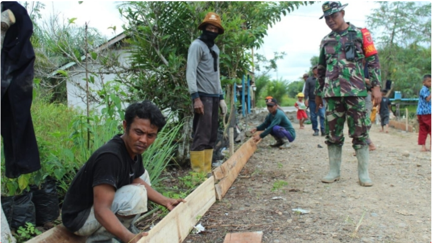
Kembali Persiapkan Pengecoran Satgas TMMMD 115 Pasang Papan Bekisting
