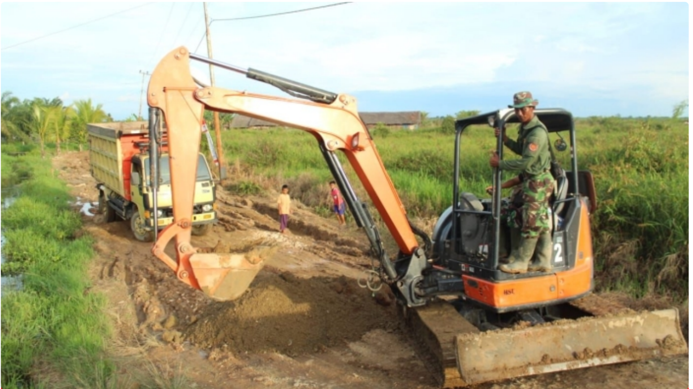
Satgas TMMD ke-115 Kodim 1001/Hsu-Blg Kerahkan Excavator
