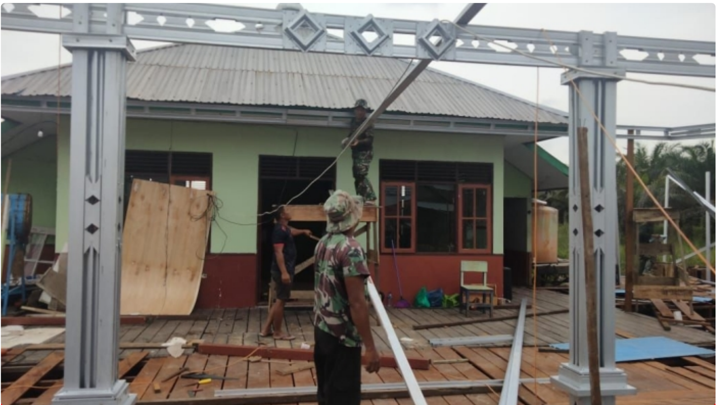
Pengerjaan Lantai dan Atap Tempat Ibadah Sebagai Sasaran Fisik TMMMD
